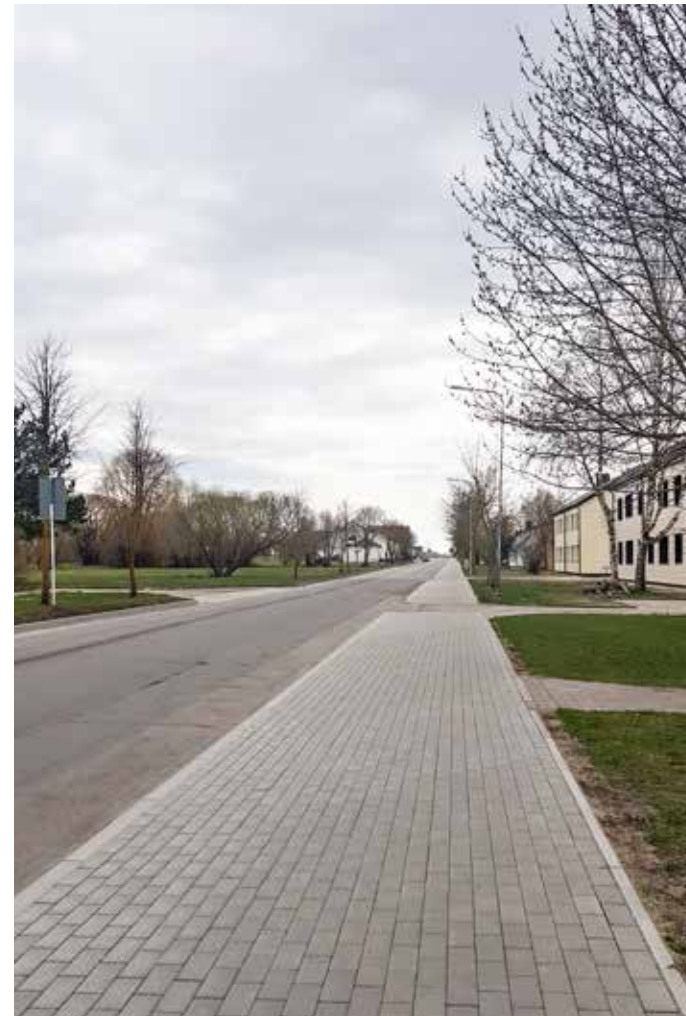
Gyventojai jau spėjo įvertinti atnaujintą Vilniaus gatvės (Pakruojis) šaligatvį.
