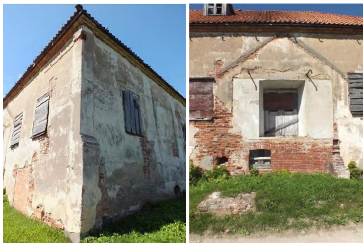
3.4. pav. Linkuvos karmelitų vienuolyno ansamblio vienuolyno namo langai Šaltinis: statybos darbų techninis projektas
