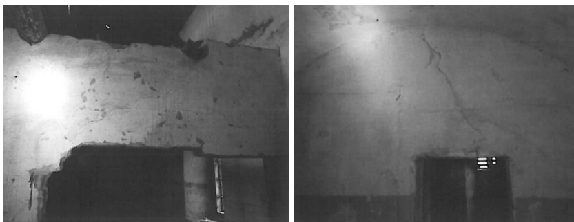
3.1. pav. Pavojingi įtrūkiai sąraminėje sienos dalyje
