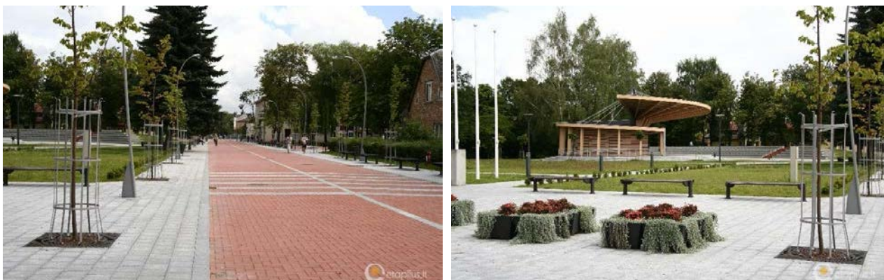
2.11.5 pav. Rekonstruota Joniškio miesto Žemaičių gatvė ir viešoji erdvė.
