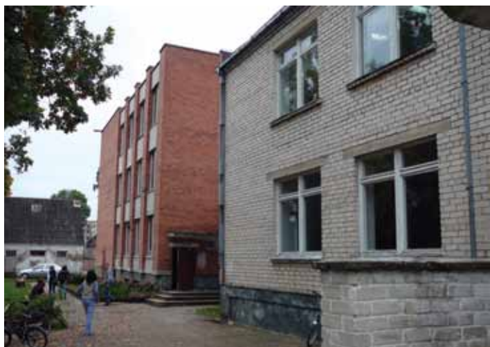
Žeimelio vidurinės mokyklos pastatas prieš ir po renovacijos
